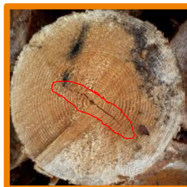
Crăpătură frontală superficială de inimă
